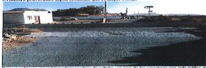
Como se observa, no existen ninguna clase de señales, en una de las carreteras con más tráfico de Triquivijate.
